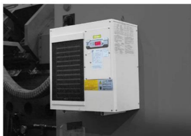
• Klimatizace el. skříně
